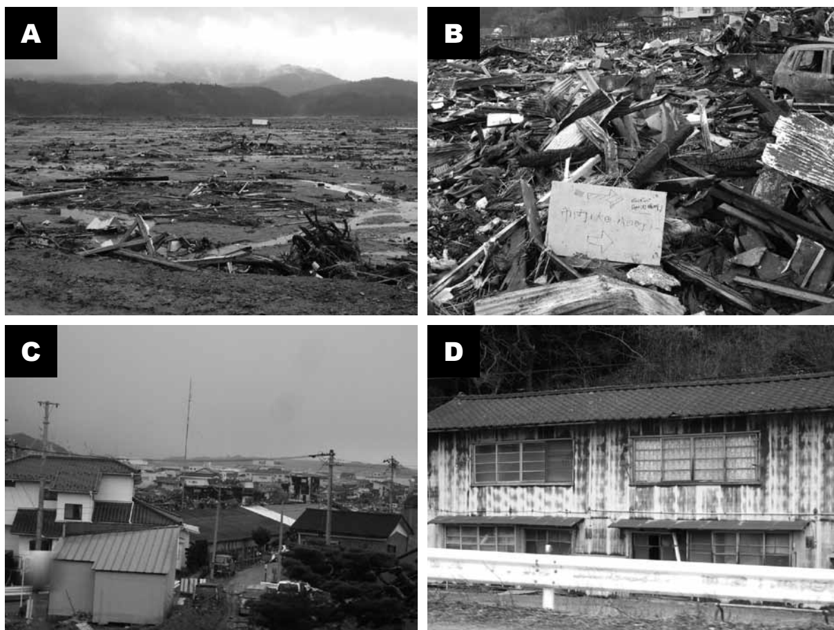
図1 気仙沼市の被害状況
