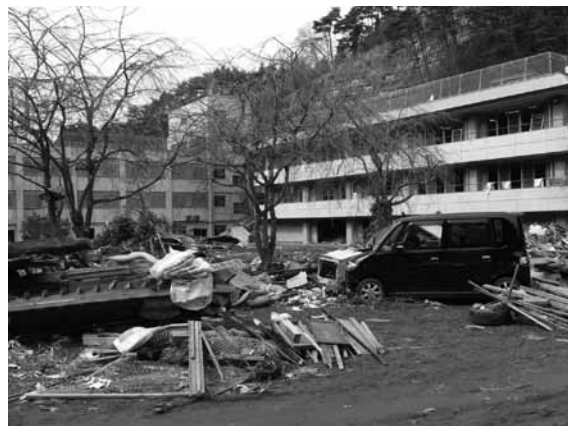
図5 被災した精神科病院
